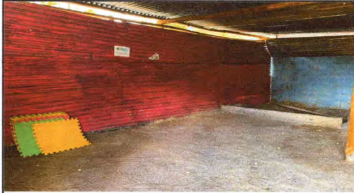
Foto 1: Sustitución de muro y/o paredes de lámina por mampostería formal (incluye piedra, arena de fundición, hierro, alambre de amarre, block, cemento).
